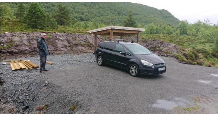
05.07.2022. Øystein godt i gang med bygging.
