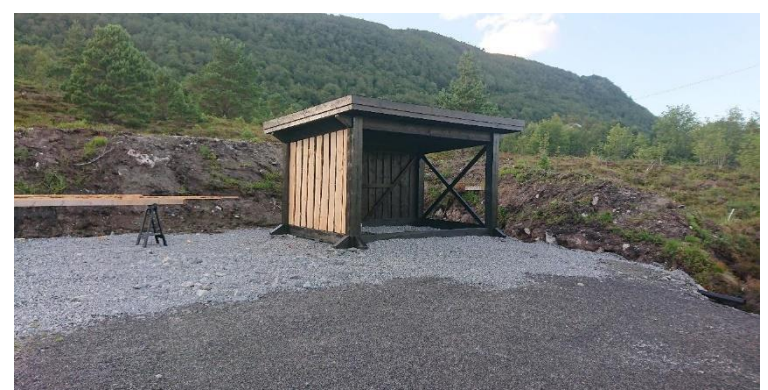
22.08.2022. Tak klart, vegger i gang.
