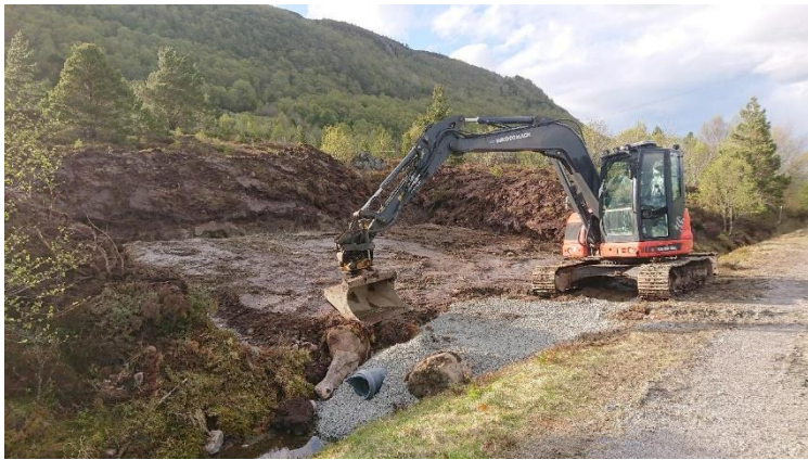
10.05.2022 Gravearbeidet endelig i gang.
