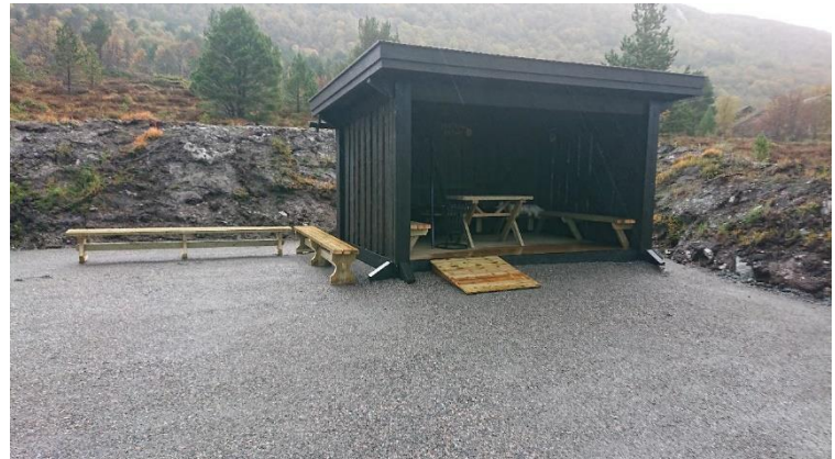
06.10.2022. Gapahuk, benker, bord og rampe ferdig.
