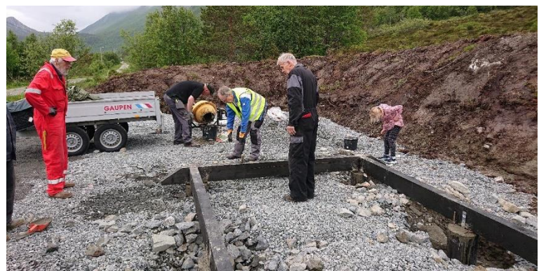
15.06.2022. Dugnad, støpning av fundament
