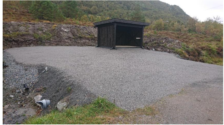
25.09.2022. Planering og grusing ferdig.
