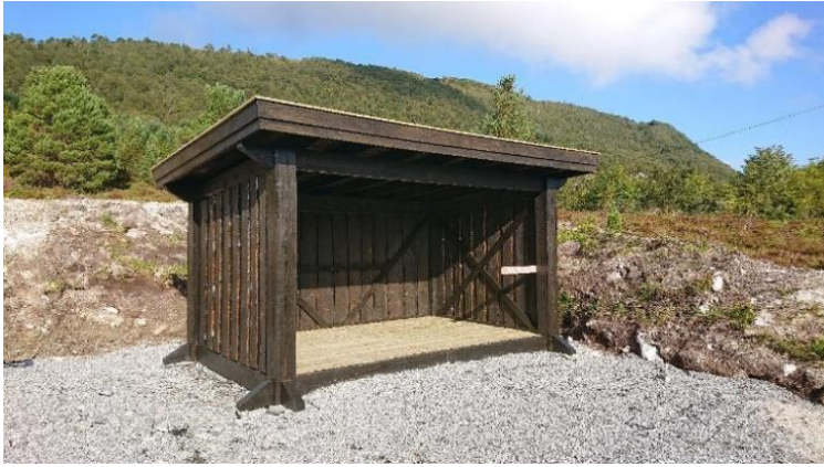
04.09.2022. Byggeprosess ferdig, gulv på plass.
